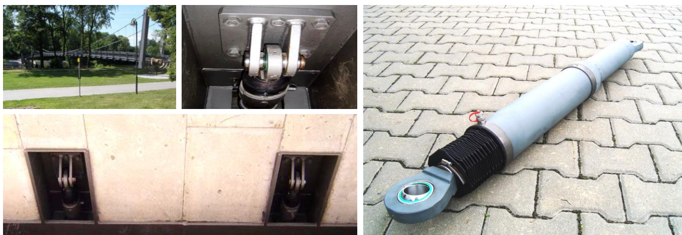
Hydraulický tlumič kmitů na lávce ke Strakonickému hradu
